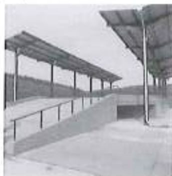
Figură 4-1 Stație de transfer
